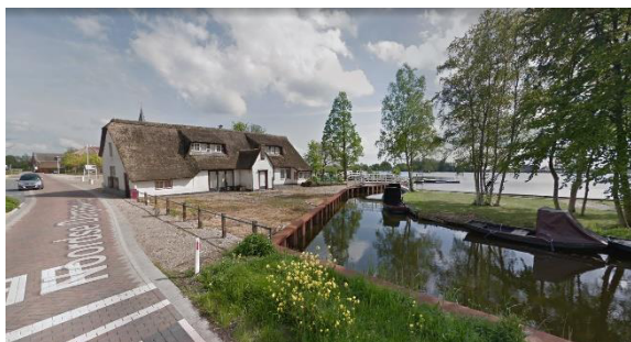
Foto 3.1: Zicht op westgevel bestaande inrichting (inclusief zicht op gedeelte Nieuwkoopse plas)
