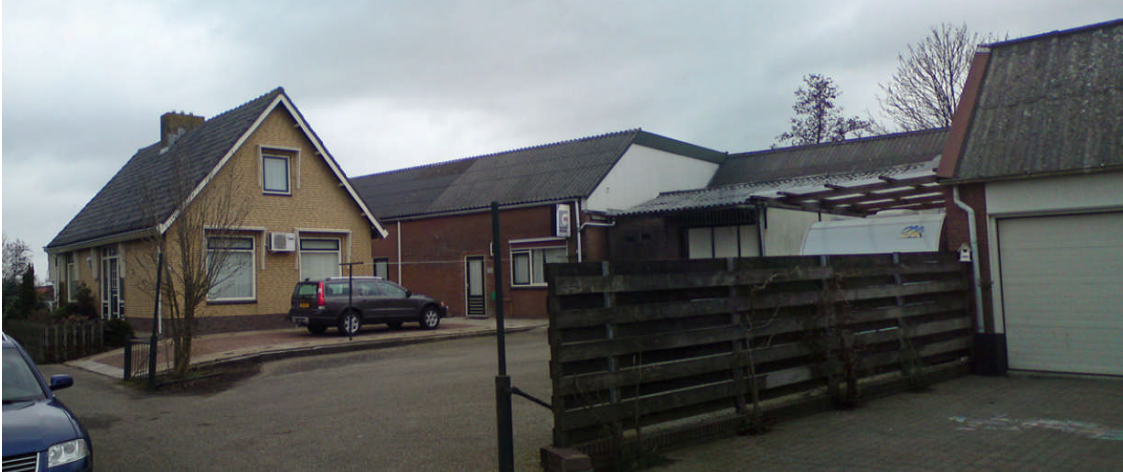
Afbeelding 4: Bestaande situatie vanaf Vijverhofpad.
