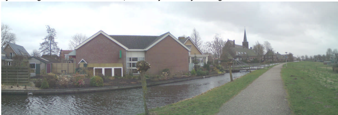
Afbeelding 3: Bestaande situatie, achterzijde vanaf de ringsloot.
