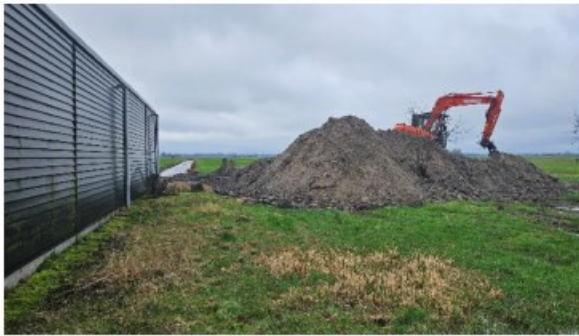
Figuur 4. Aanzicht op de grondhoop en sporthal. Aan de grondhoop wordt dagelijks gewerkt. Zodra het plangebied droog is zal het gebied met de grond worden geëgaliseerd.
