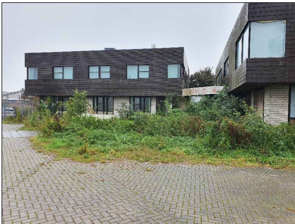
Figuur 1 De te saneren/renoveren bebouwing op de planlocatie bestaat uit drie bouwlagen en is omringt door woekerende vegetatie.
