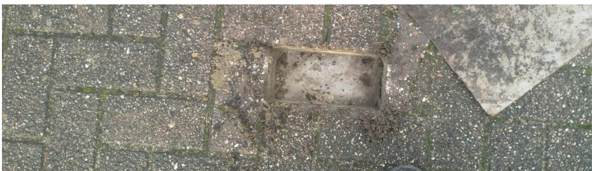
Boring 6: beton direct onder de tegels
