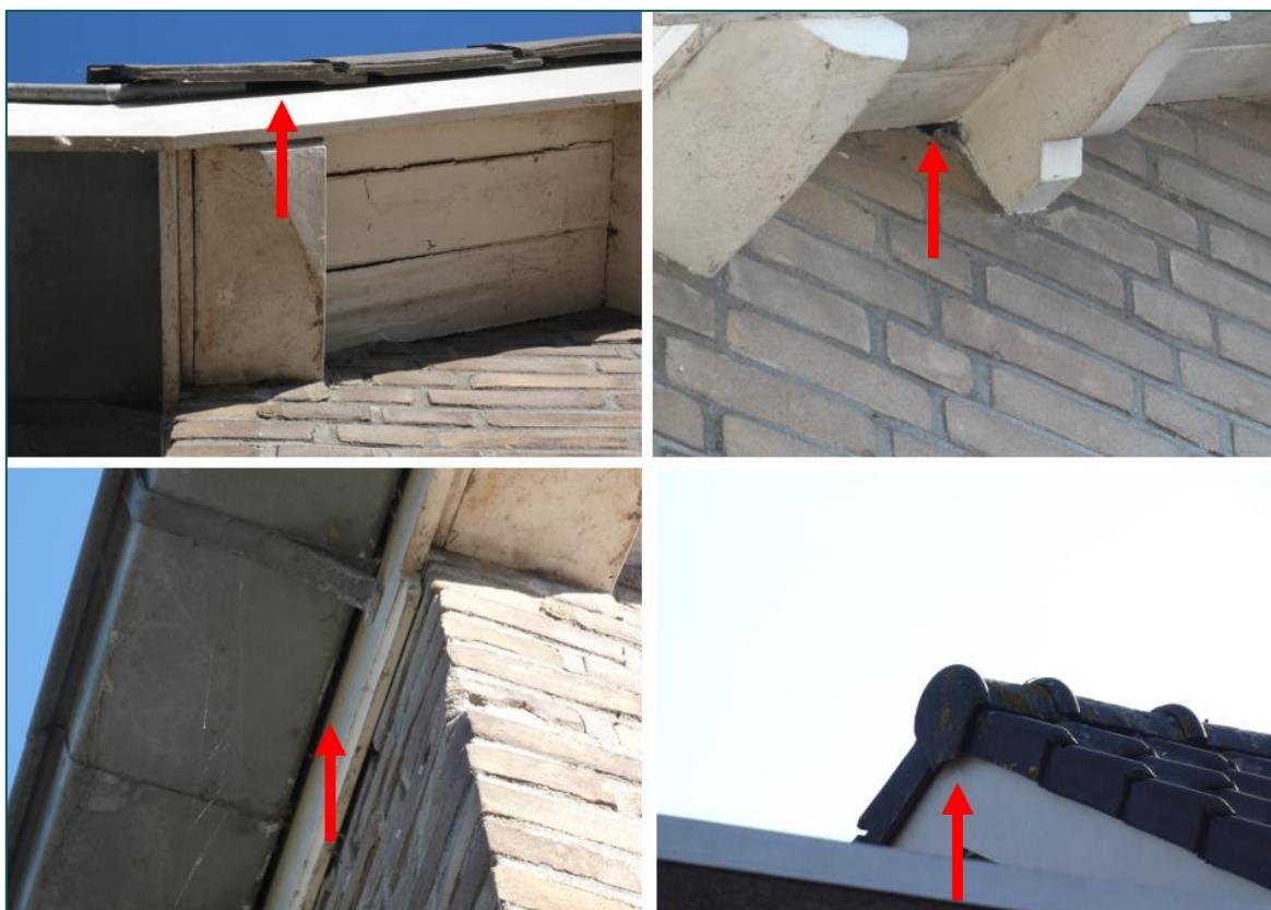
Figuur 3.2 Potentiële invliegopeningen voor vleermuizen in het schoolgebouw (gebouw 2 in figuur 1.2).
