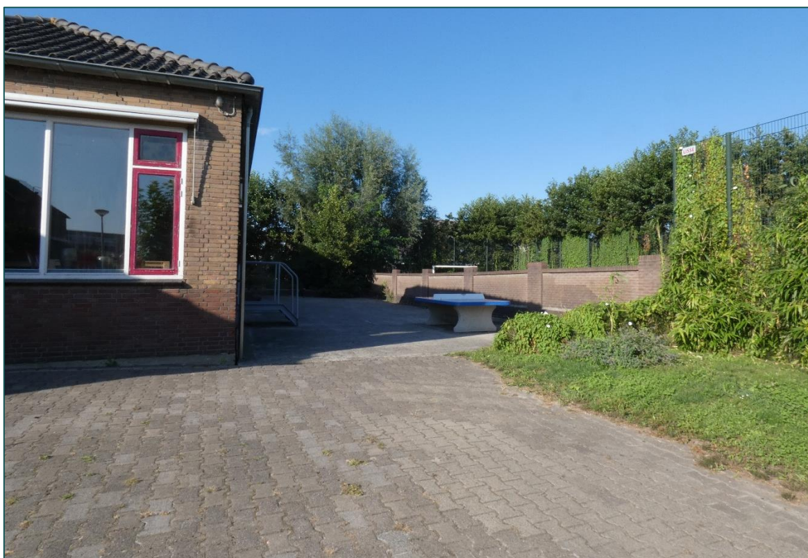
Figuur 3 Het terrein rond het dorps huis is grotendeels verhard.
