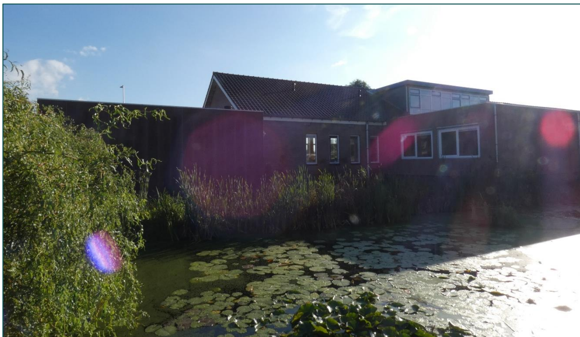
Figuur 6 De achterzijde van de school is gelegen aan een watergang.
