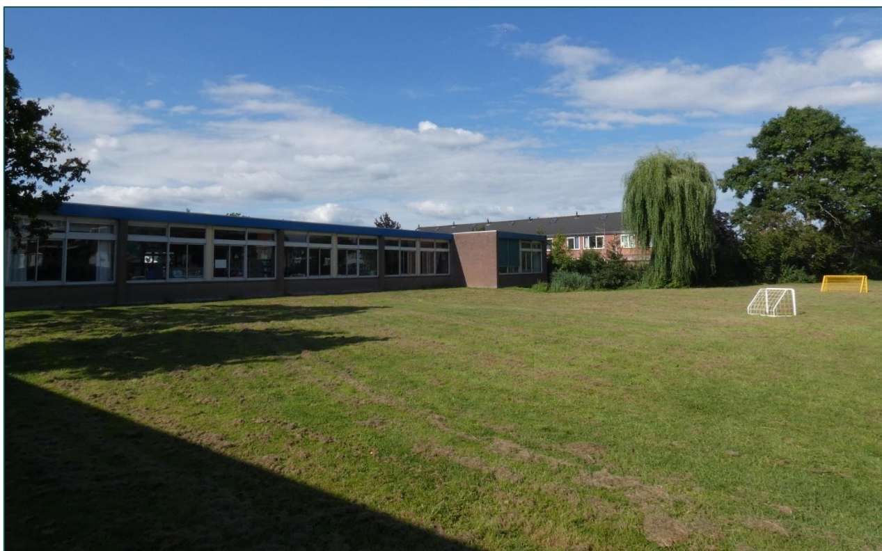
Figuur 4 Naast het schoolgebouw is een grasveld aanwezig.
