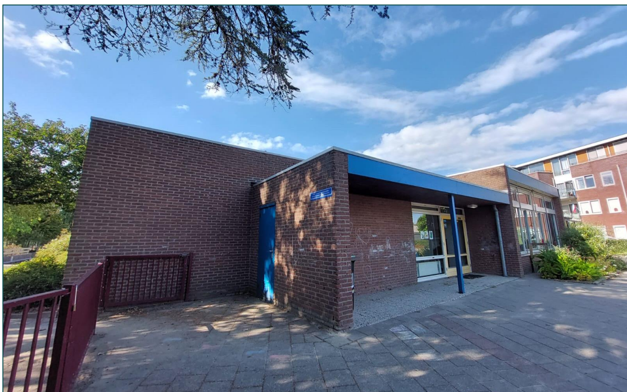
Figuur 2 De bebouwing is opgetrokken uit gemetselde muren met spouw.
