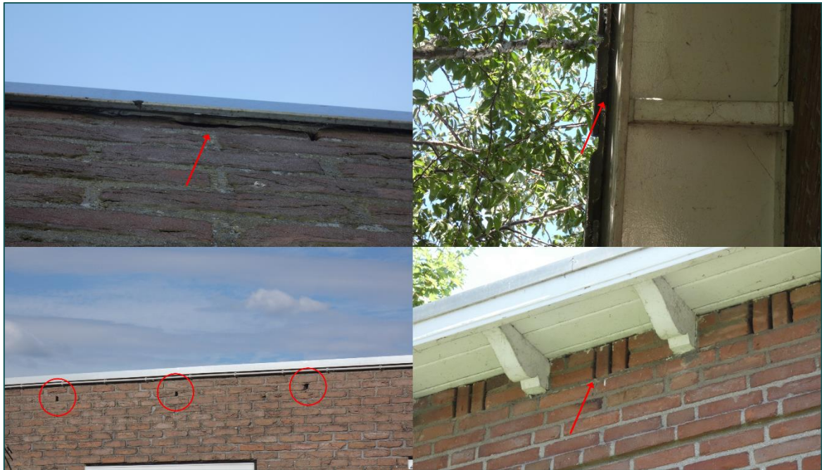
Figuur 3.1 In de bebouwing zijn verschillende openingen aanwezig die toegang bieden tot de open spouwruimte en/of dakruimte.
