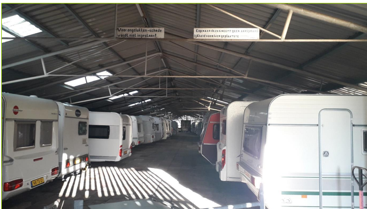
De loods voor de caravanstalling bestaat uit een enkele laag golfplaten als dak en dunne wanden van o.a. golfplaten als muren
