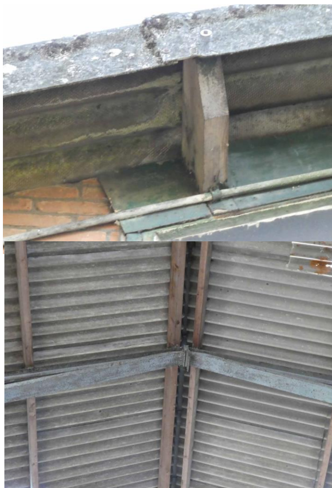
Figuur 8: Binnenzijde dakconstructie van ethanietplaten
