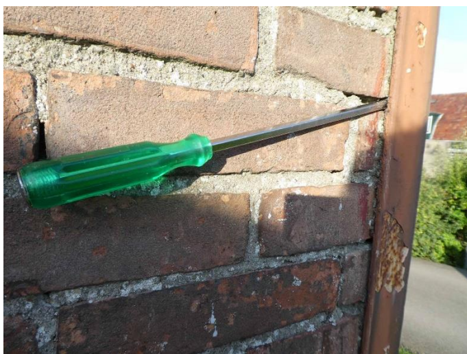
Figuur 9: Schroevendraaier blijft klemmen tussen de muur en hoekprofiel
