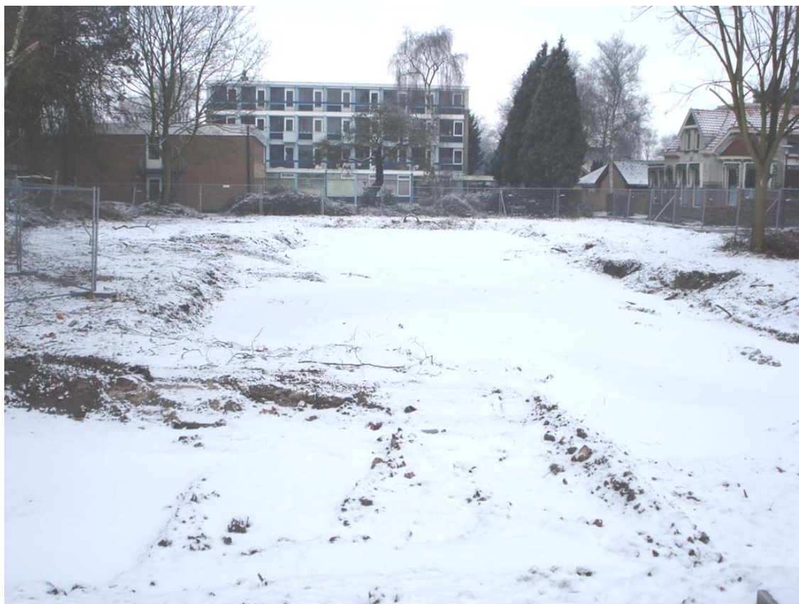
Afbeelding 1.3: Huidige situatie van het oostelijk deel van het plangebied, langs de Muggenlaan.
