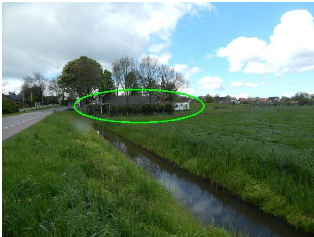
Voor- en zij aanzicht te slopen schuur
