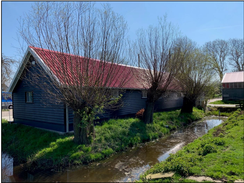
Figuur 5 Stal '3' zal zonder bouwkundige aanpassingen in gebruik worden genomen als ontbijtruimte.
