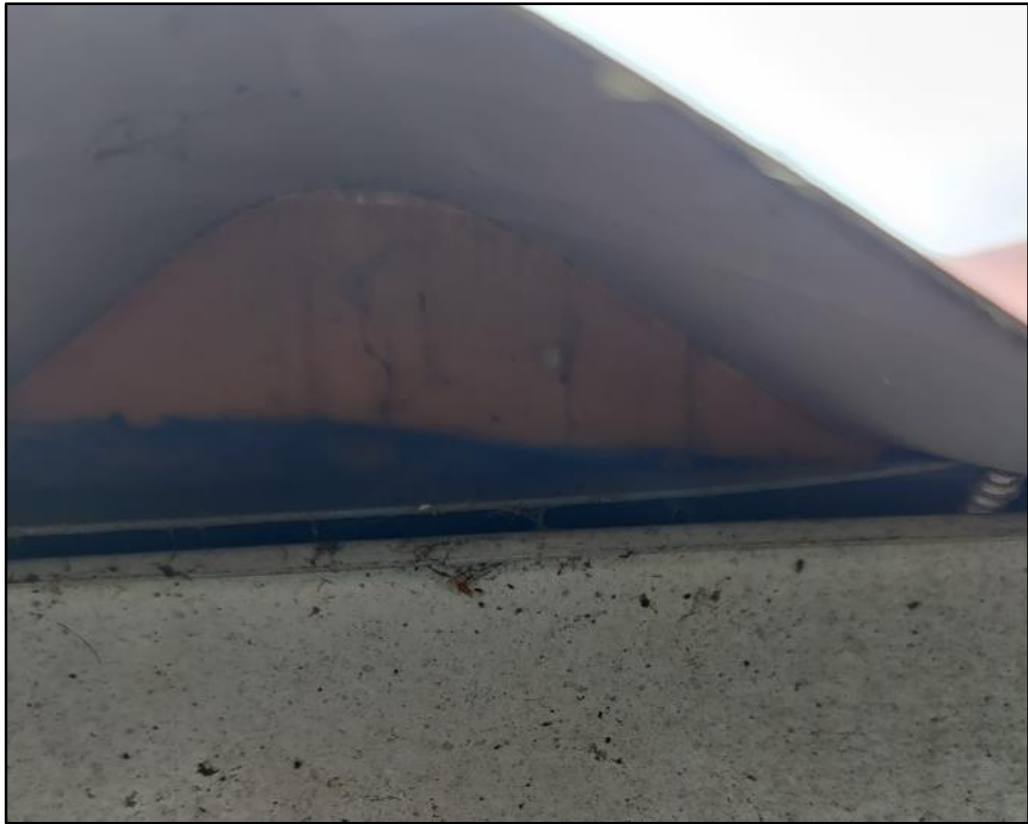
Figuur 3 De stal '3', welke behouden blijft binnen de beoogde ontwikkeling, beschikt over isolatiemateriaal onder het golfplaat waardoor geen geschikte nestlocaties aanwezig zijn voor de huismus.
