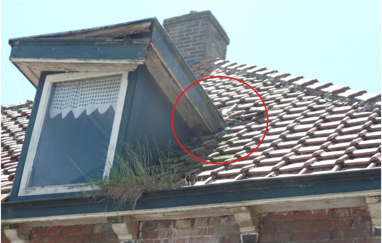
Figuur 5: Waargenomen invliegopening van de Gierzwaluw bij de dakkapel van de noordoostelijke zijgevel.
