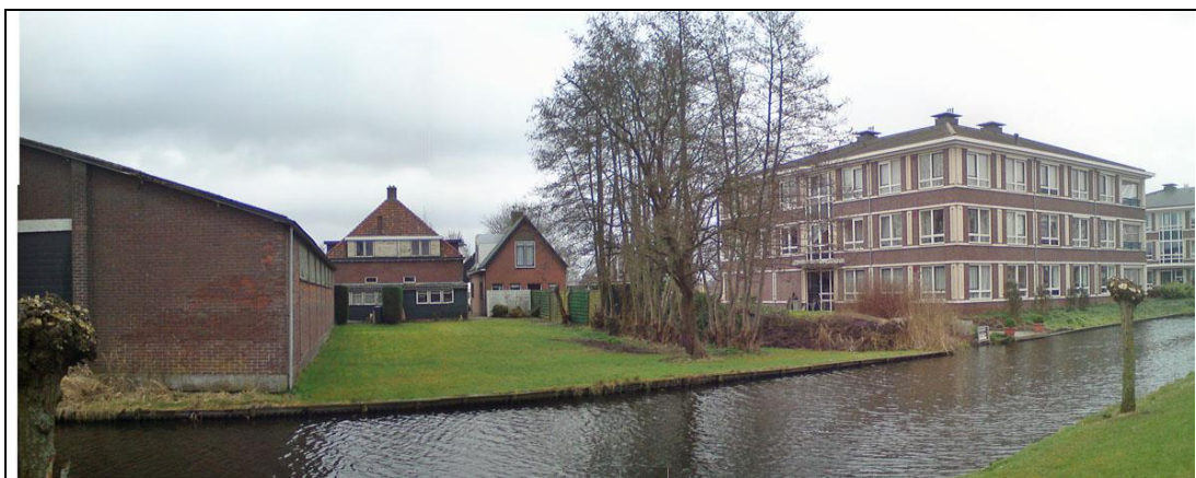
Afbeelding 4: Bestaande situatie, achterzijde vanaf de ringsloot.
