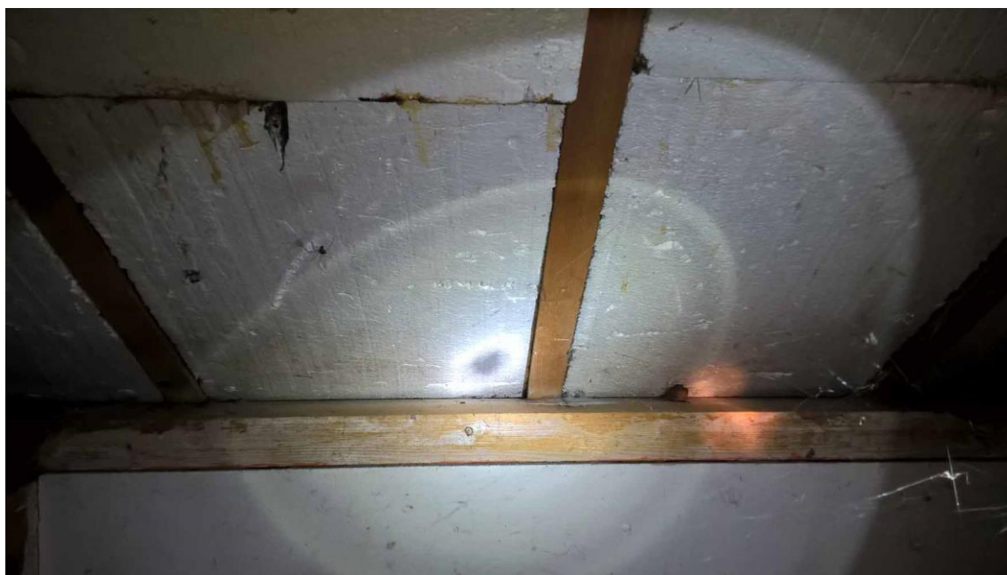
Figuur 12: Binnenkant rietdak afgewerkt met isolatiemateriaal
