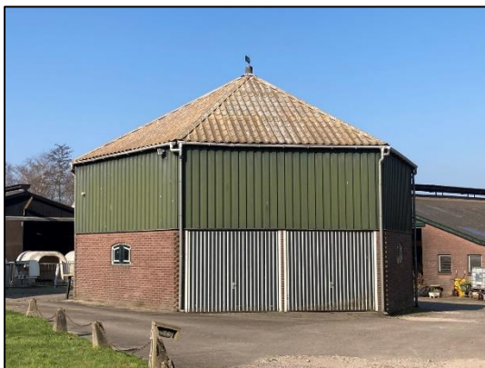
Figuur 2.22 (links): De hooischuur in het midden van het perceel bevat garagedeuren, muren die deels gemetseld en deels van damwand zijn en een golfplaten dak. .
