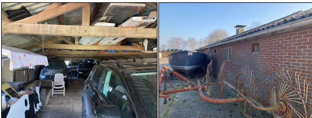
Figuur 2.7 (links): De binnenkant van de opslag bestaat uit niet geïsoleerd dak, verder staan er materialen opgeslagen; Figuur 2.8 (rechts): De westzijde van de opslag, waar materialen naast staan opgeslagen. De kozijnen zijn gemetseld en vertonen geen kieren.
