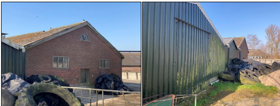
Figuur 2.5 (links): De achterzijde van het gemetselde deel van de opslag, met op de voorgrond een zogenoemde rommelhoop; Figuur 2.6 (rechts): De achterzijde van de opslag.
