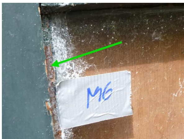
Foto 35 | Foto voor bron Beglazingskit
