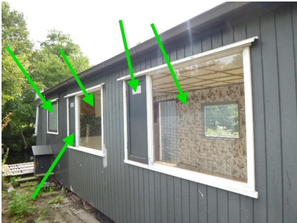
Foto 44 | Foto voor bron Beglazingskit (caravan 2)
