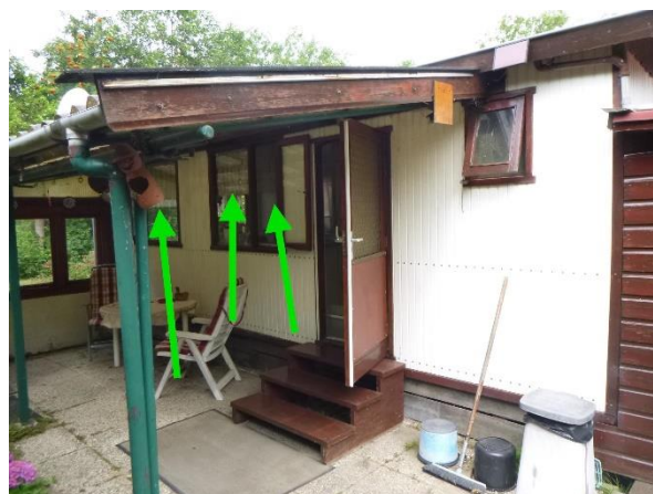
Foto 39 | Foto voor bron Beglazingskit (caravan 2)
