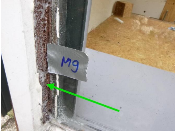
Foto 42 | Foto voor bron Beglazingskit (caravan 2)
