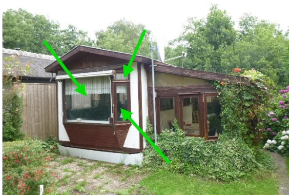
Foto 38 | Foto voor bron Beglazingskit (caravan 2)
