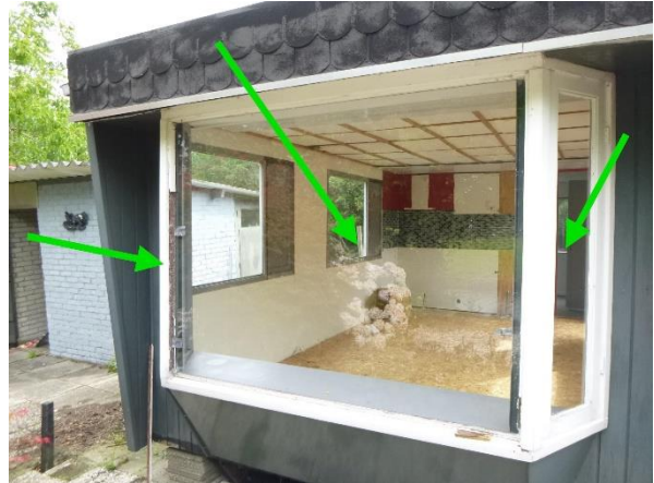
Foto 43 | Foto voor bron Beglazingskit (caravan 2)
