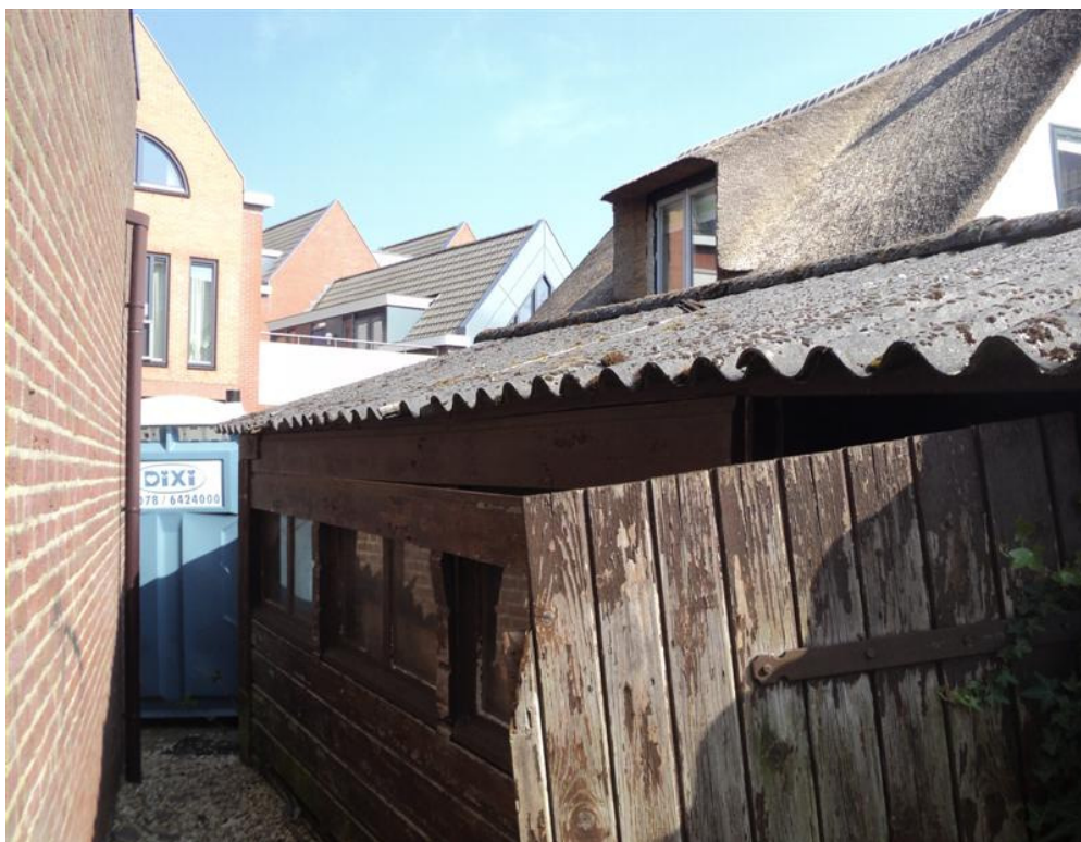
Figuur 5: Golfplaatdak van het af te breken schuurtje.
