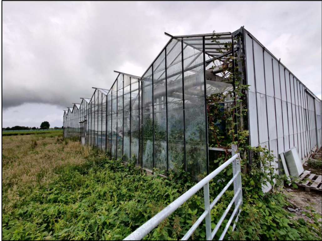
Figuur 3 Aan de achterkant van het kassencomplex zijn openingen aanwezig.
