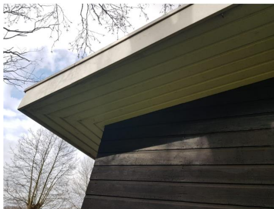
Figure 20. Te verwijderen bungalowwoning, detailfoto.
