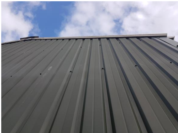
Figuur 17. Te slopen schuur, geen ruimte aanwezig onder de dakrand.
