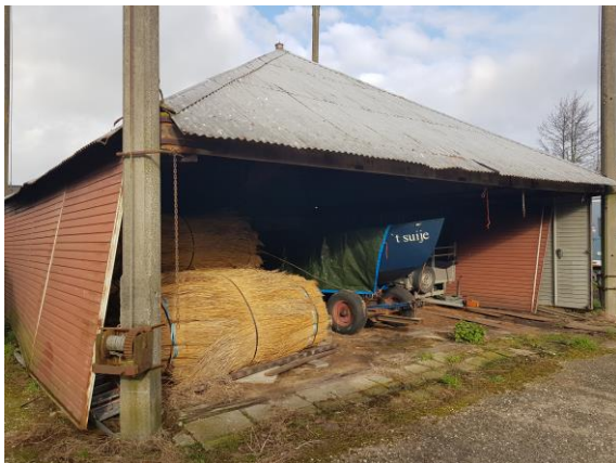
Figuur 9. Een van de te slopen opstallen, op dit moment in gebruik als opslagplaats.
