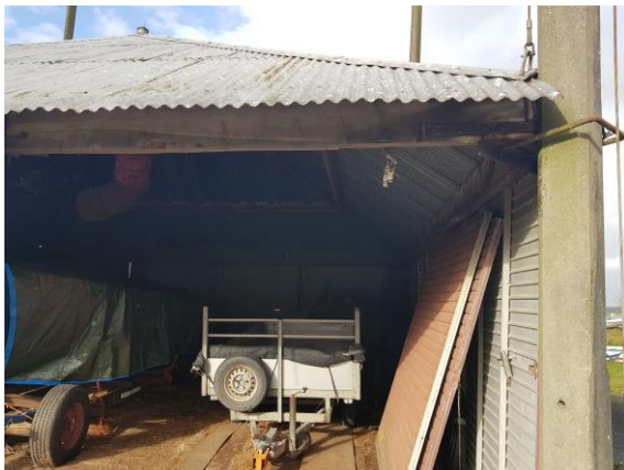
Figuur 11. Een van de te slopen opstallen, op dit moment in gebruik als opslagplaats.
