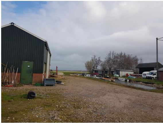
Figuur 15. Te slopen schuur vooraanzicht.
