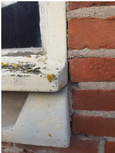
Figuur 7. Raam in een van de te slopen stallen, geen ruimte aanwezig tussen het kozijn en bakstenen muur.
