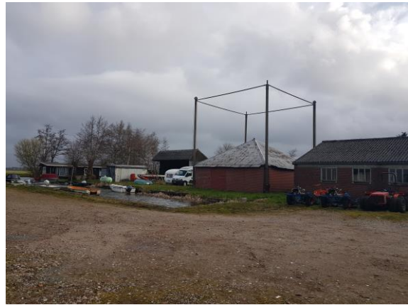
Figuur 16. Te slopen opstallen, kijkrichting richting het oosten.
