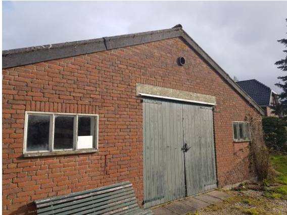
Figuur 3. Een van de te slopen stallen. Deze stal heeft geen spouwmuur.
