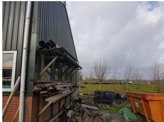
Figuur 18. Te slopen schuur achteraanzicht.
