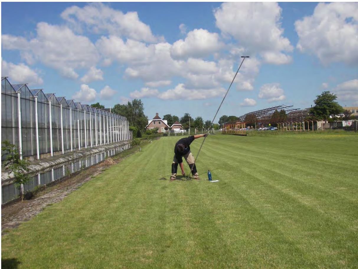
Figuur 12: Het zetten van boring 10 (gezien van zuidelijke richting).
