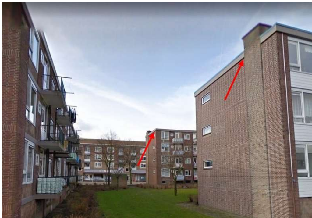
Figuur 8. Uitvlieglocaties gewone dwergvleermuis in complex 7 (achter) en complex 9 (voor).
