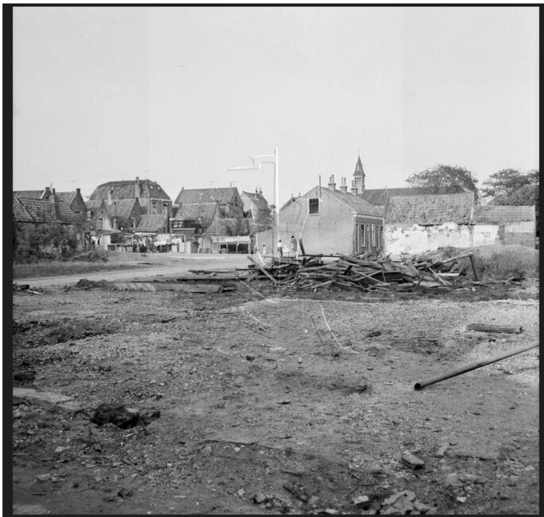
Figuur 9: Foto van tijdens de sloop van de oude bebouwing omstreeks 1959 genomen in oostelijke richting met op de achtergrond de Schuurkerk. (Bron: https://hvm.collectiebank.nl/ )
