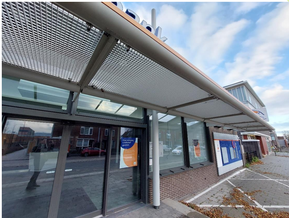
Figuur 8. Oude hoofdingang van het Rabobankkantoor met de dichtgemaakte pinapparaten aan de gevel.
