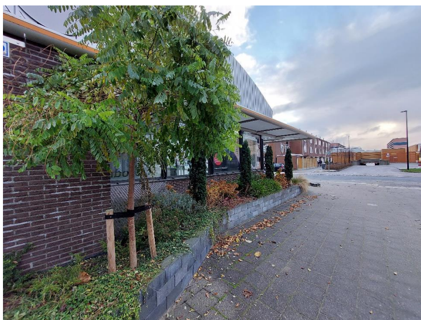
Figuur 11. Het oude Rabobankkantoor gezien vanuit het zuidwesten.
