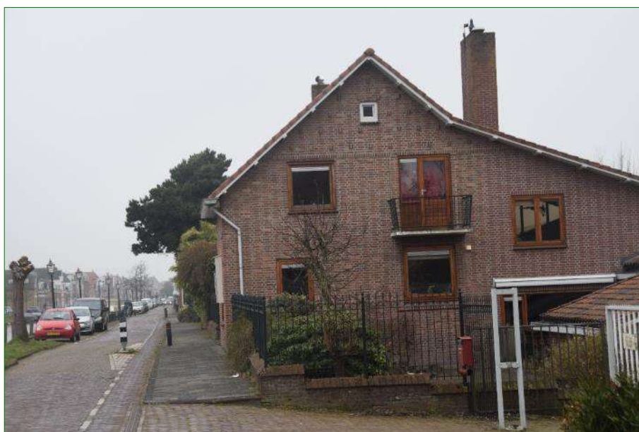
Bestaande en te handhaven woonhuis: Noordvliet 159a.
