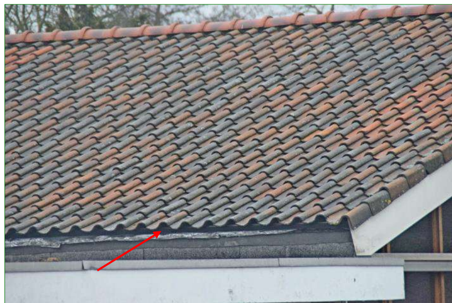
De openingen bij de onderste rij dakpannen kan Huismussen toegang geven tot geschikte ruimten.
