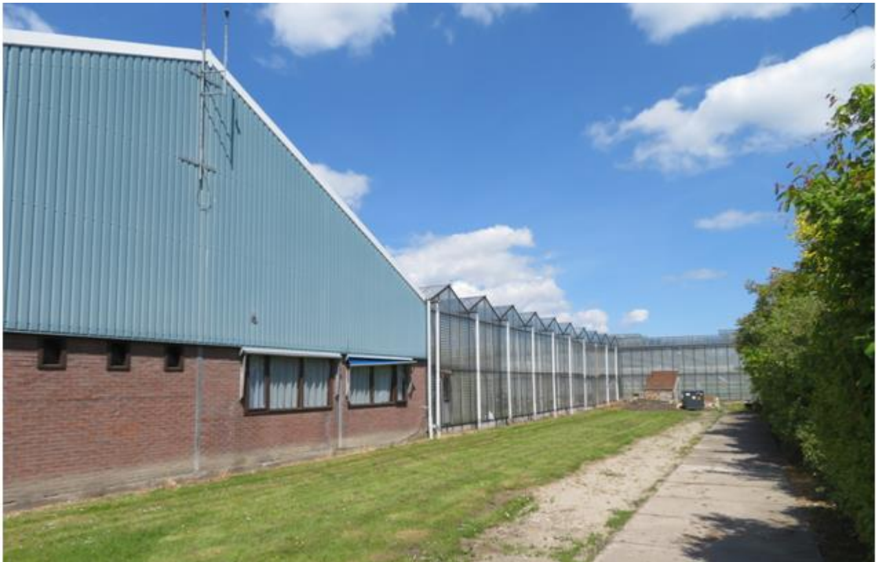
Bedrijfshal en kassencomplex welke worden gesloopt.
