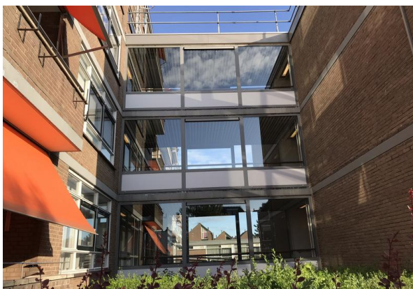
Figuur 8. Detail van de noordelijke zijde van het appartementencomplex, gezien vanaf de Zuidvliet.
