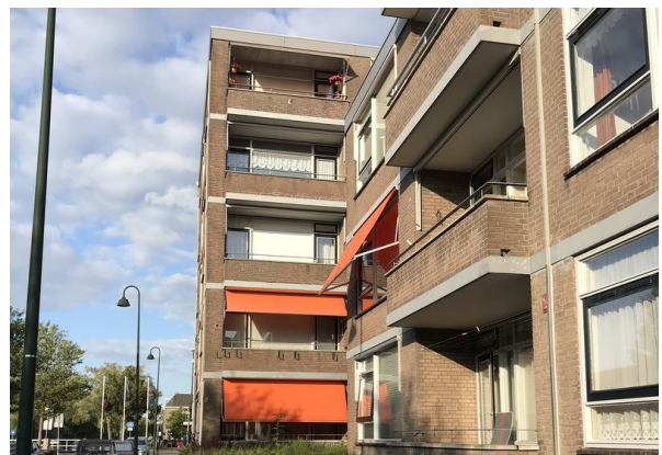
Figuur 7. Detail van de noordelijke zijde van het appartementencomplex, grenzend aan de Zuidvliet.
