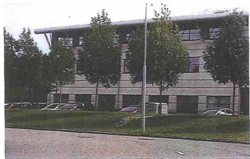
parkeren en opslag 'verstoep' achter een talud
