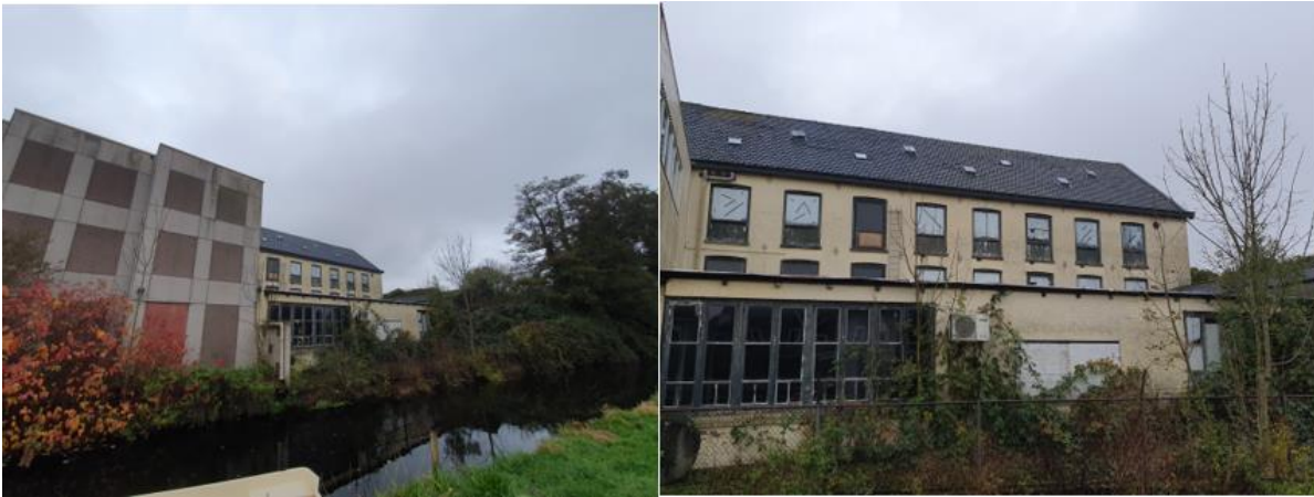
B: Foto-impressie bedrijfsgebouw. Links overgang van oude naar nieuwe deel, rechts oostzijde oude deel
