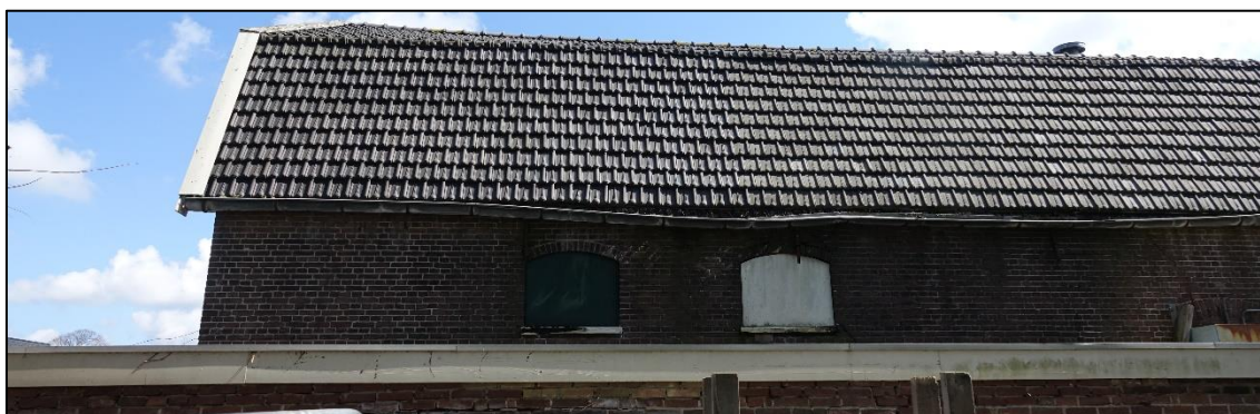
Figuur 16: De onderzijde van het dak lijkt goed toegankelijk, waardoor een functie voor huismussen en gierzwaluwen aanwezig kan zijn.
