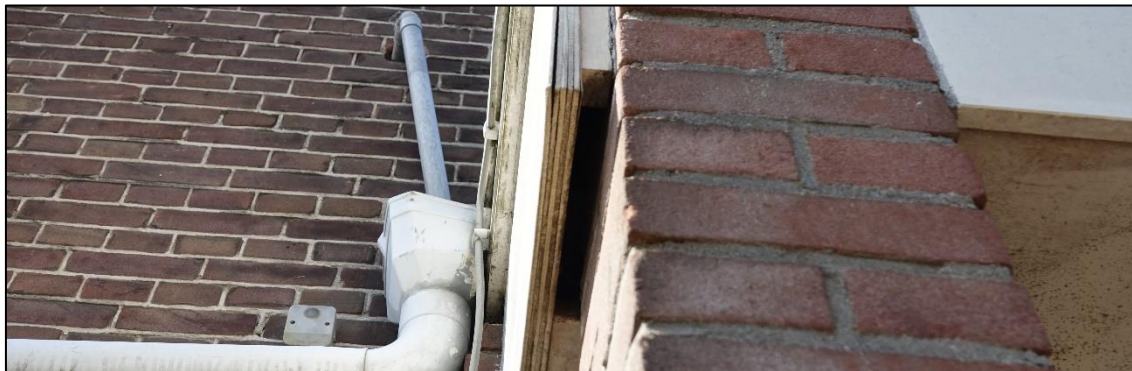
Figuur 15: Openingen in de boeiboorden en gevelbetimmering zijn bij uitstek geschikte verblijfplaatsen voor dwergvleermuizen.
