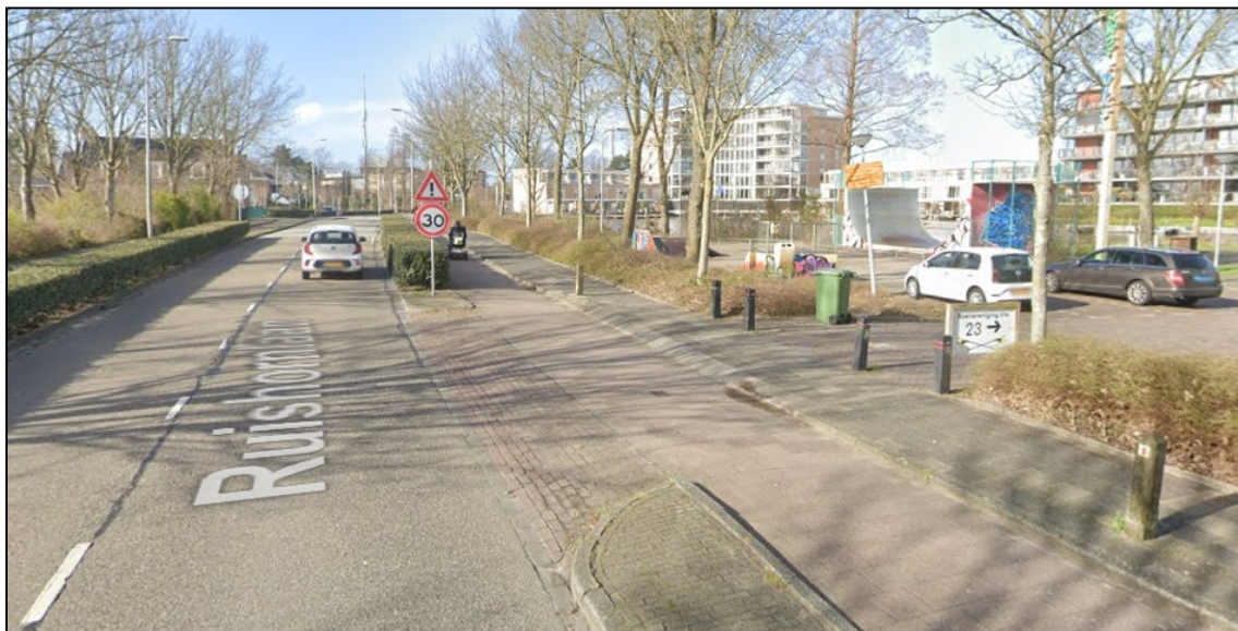
Figuur 2.1: Aansluiting Ruishornlaan 21 en 23
