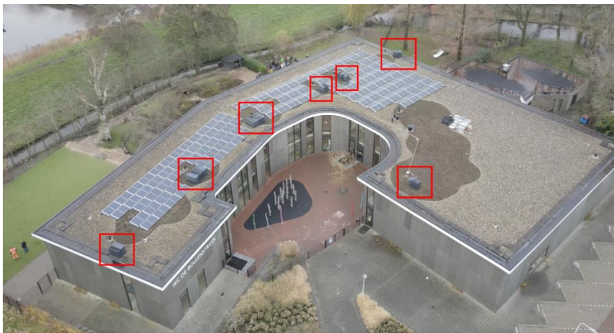
f 4.2 Luchtfoto van het dak van het IKC
