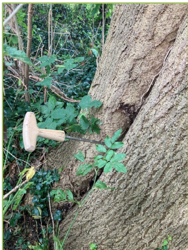
Figuur 2: Stamrotting bij boom 40, momenteel nog voldoende resterend gezond hout aanwezig. Mogelijk een toekomstige NTO boom.
