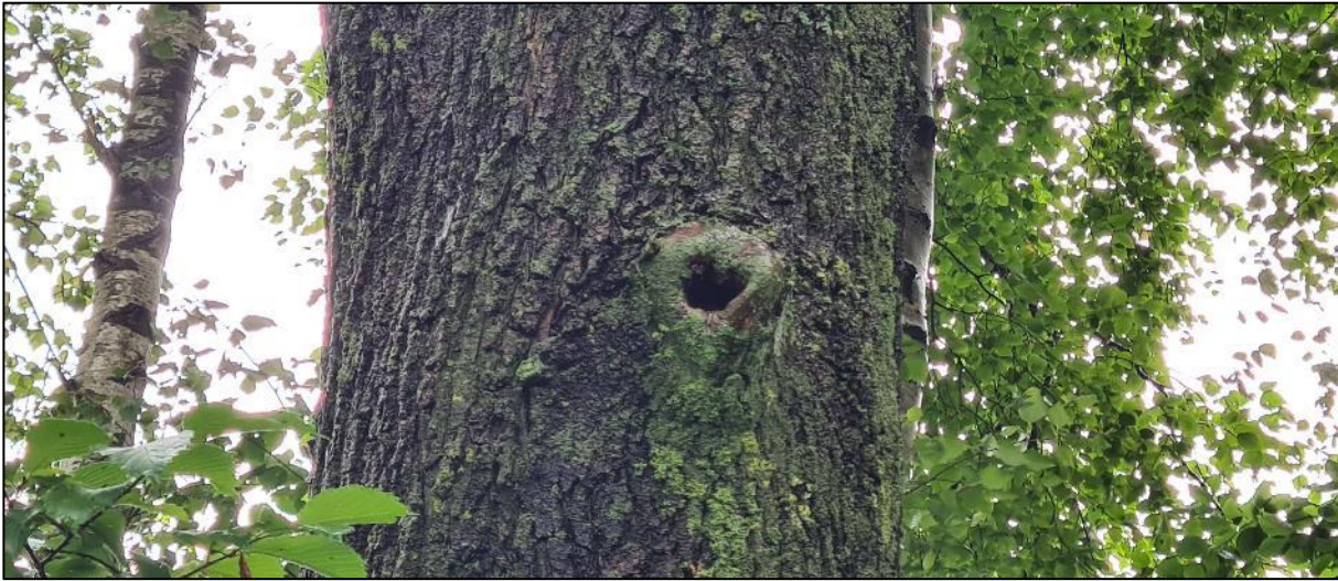
Eén van de aangetroffen ondiepe holtes in een boom binnen het plangebied. De holte is naar boven gericht waardoor water naar binnen kan lekken.
