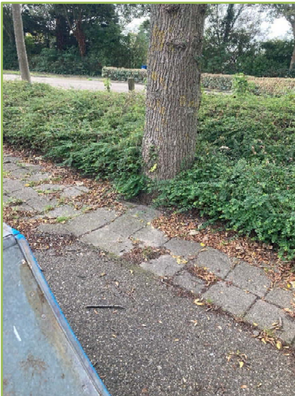
De iepen langs de skatebaan staan met de stamvoet tegen de verharding. Het valt aan te bevelen om in de nieuwe situatie de standplaats bij deze bomen te verruimen.
