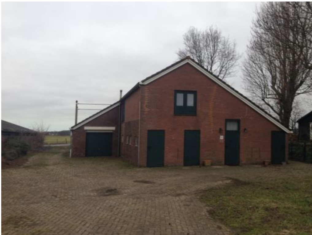
Figuur 3 Afgebeelde schuur bestaat uit verschillende componenten en heeft diverse gebruikersfuncties. Het terrein is grotendeels verhard met betonklinkers.
