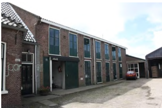
Foto 6. Te renoveren bollenschuur
