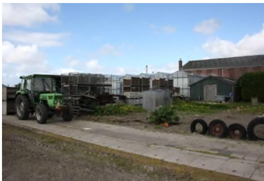
Foto 5. Te saneren kas- en schuurruimte
