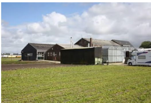
Foto 7. Te saneren kas- en schuurruimte
