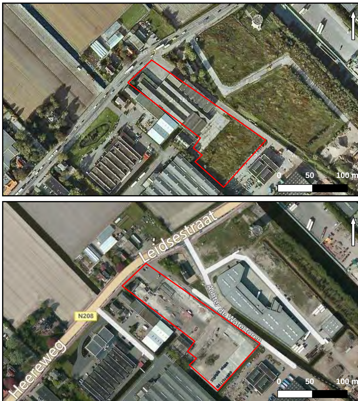
Figuur 1. Boven: luchtfoto van het plangebied met bebouwing uit 2005 (bron: Google Earth) Onder: luchtfoto uit 2010, tijdens de sloop van de bebouwing (bron: Bing Maps).
