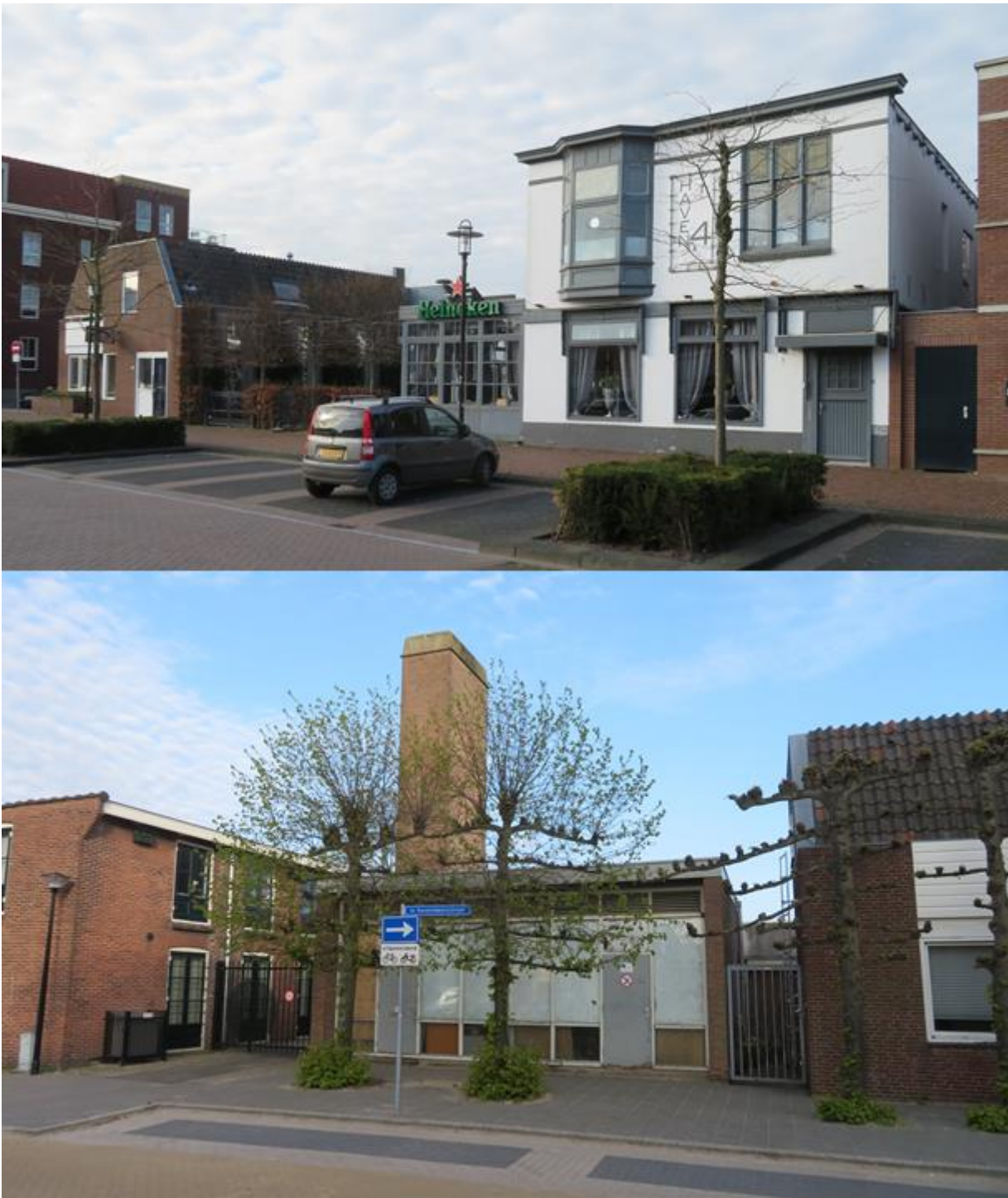
Fig. 4: Boven: Haven 4 (witte pand en grijze laagbouw met Heineken reclame). Onder vrijstaand ketelhuis (achter leibomen) en bijbehorende schoorsteen.
