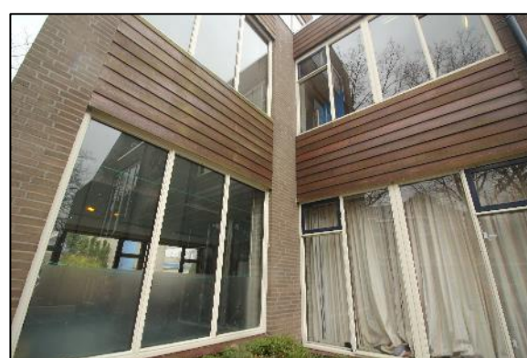
Foto 6: Te slopen gebouw met gevelbetimmering
