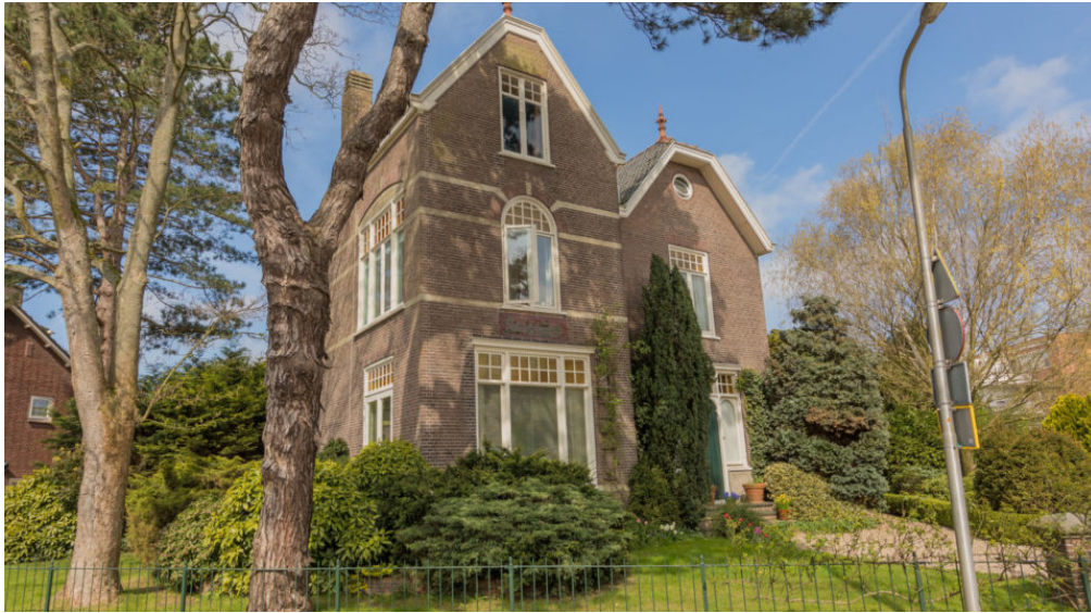
Villa op de hoek, 45 graden gedraaid richting de Lindenlaan, Achterweg 8
