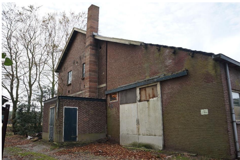
Achtergevel met uitbouw en rechts de recente aanbouw .
