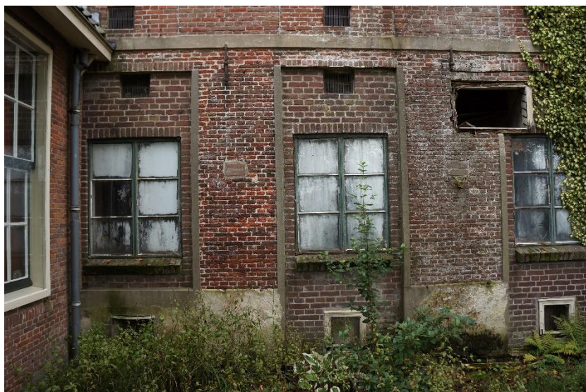
Detailopname zijgevel (zuid)
