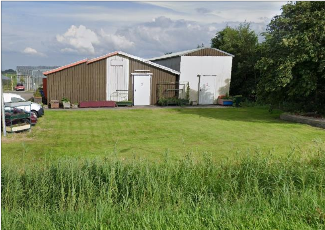
Figuur 6: De schuur die zal worden gesloopt om ruimte te maken voor de creatie van een bouwvlak.
