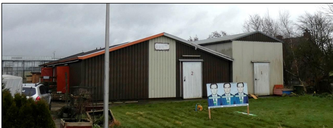
Figuur 3: De schuur en één van de koelcellen.
