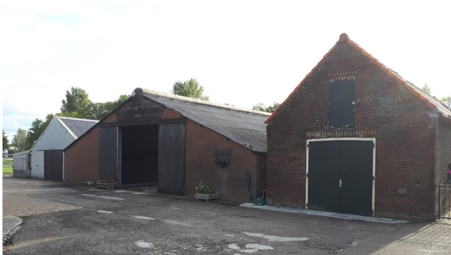
Zicht op enkele stallen met rechts de wagenschuur, gebouwen links daarvan inmiddels gesloopt
