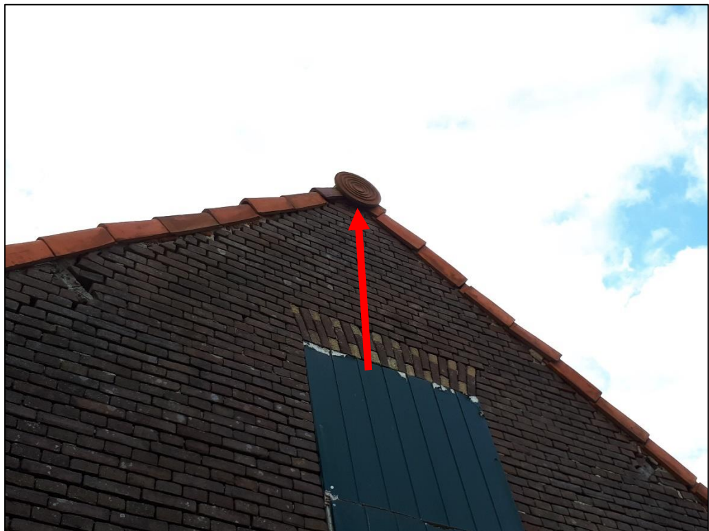
Potentiële nestplaats van de gierzwaluw in de oude wagenschuur.
