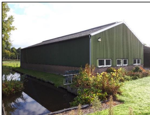
Aanzicht noordwestzijde schuur 1.
