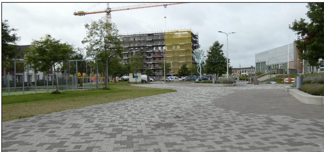
Figuur 6: Het plein tussen het Fioretti College en de parkeerplaats. Rechts is sportcentrum De Waterkanten en links het sportveld te zien. In het midden van de foto is de parkeerplaats en het flatgebouw in aanbouw te zien.
