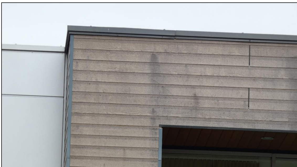
Figuur 17: Sportcentrum De Waterkanten heeft een plat dak met nauw aansluitende dakrand. De gevels zijn bekleed met gladde metalen platen en nauw op de gevel aansluitende latten. Het sportcentrum heeft geen openingen of ruimten waar vleermuizen toegang tot een verblijfplaats kunnen hebben.
