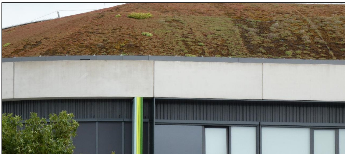
Figuur 16: Het Fioretti College is opgetrokken uit beton met metalen gevelplaten en grote raampartijen. Het deels plat en deels groen dak heeft een nauw aansluitende dakrand. De voegen tussen de betonplaten aan het Fioretti College zijn dichtgesmeerd waardoor geen openingen aanwezig zijn waar vleermuizen gebruik van kunnen maken.
