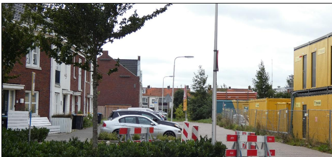
Figuur 7: De Sportlaan, gezien in de richting van de Johan Zoutmanstraat. Rechts zijn de bouwcontainers van het flatgebouw in aanbouw te zien.
