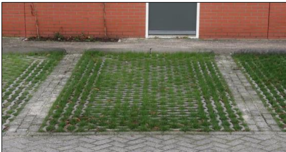
Figuur 3: Halfverharding bij parkeerplaatsen (bron:duurzaamdenhaag.nl).
