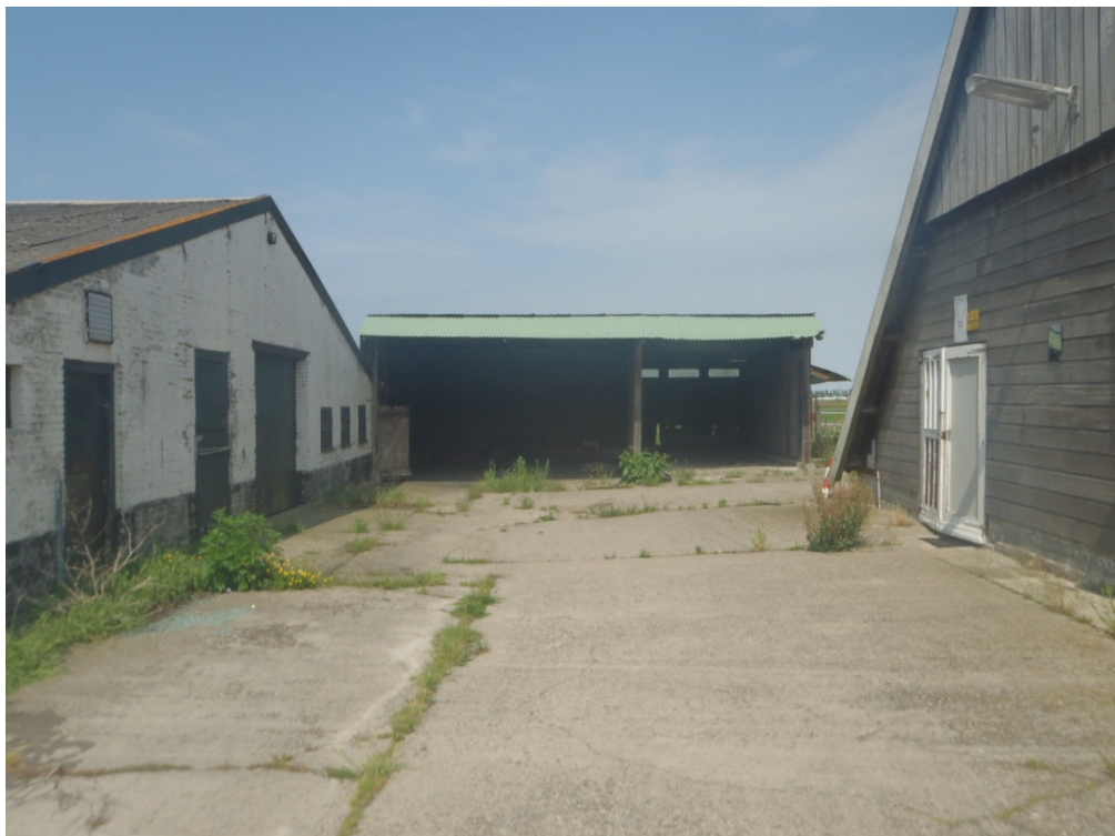
Foto 6: betonverharding tussen de schuren op het voterrein.
