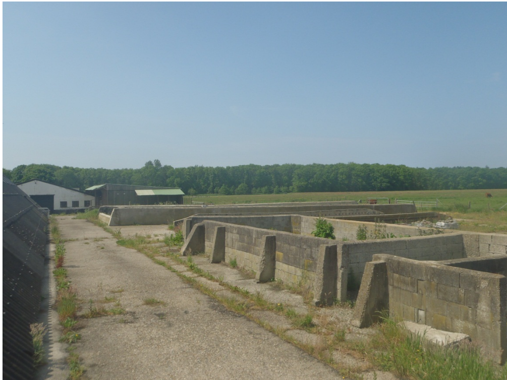
Foto 7: aanwezige betonbakken en betonverharding op het middenterrein op het westelijke gedeelte van de onderzoekslocatie.
