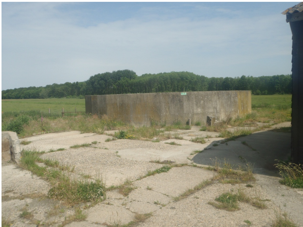
Foto 8: aanwezige ronde betonnenbak op het noordwestelijke gedeelte van de onderzoekslocatie.
