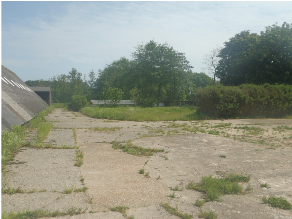
Foto 5: betonverharding gelegen aan de oostzijde van de middelste schuur.
