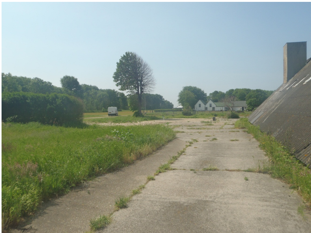
Foto 10: aanwezige betonverharding op het middensterrein, gelegen aan westzijde van de middelste schuur.
