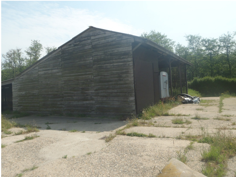
Foto 9: De meest noordelijk gelegen houten schuur.
