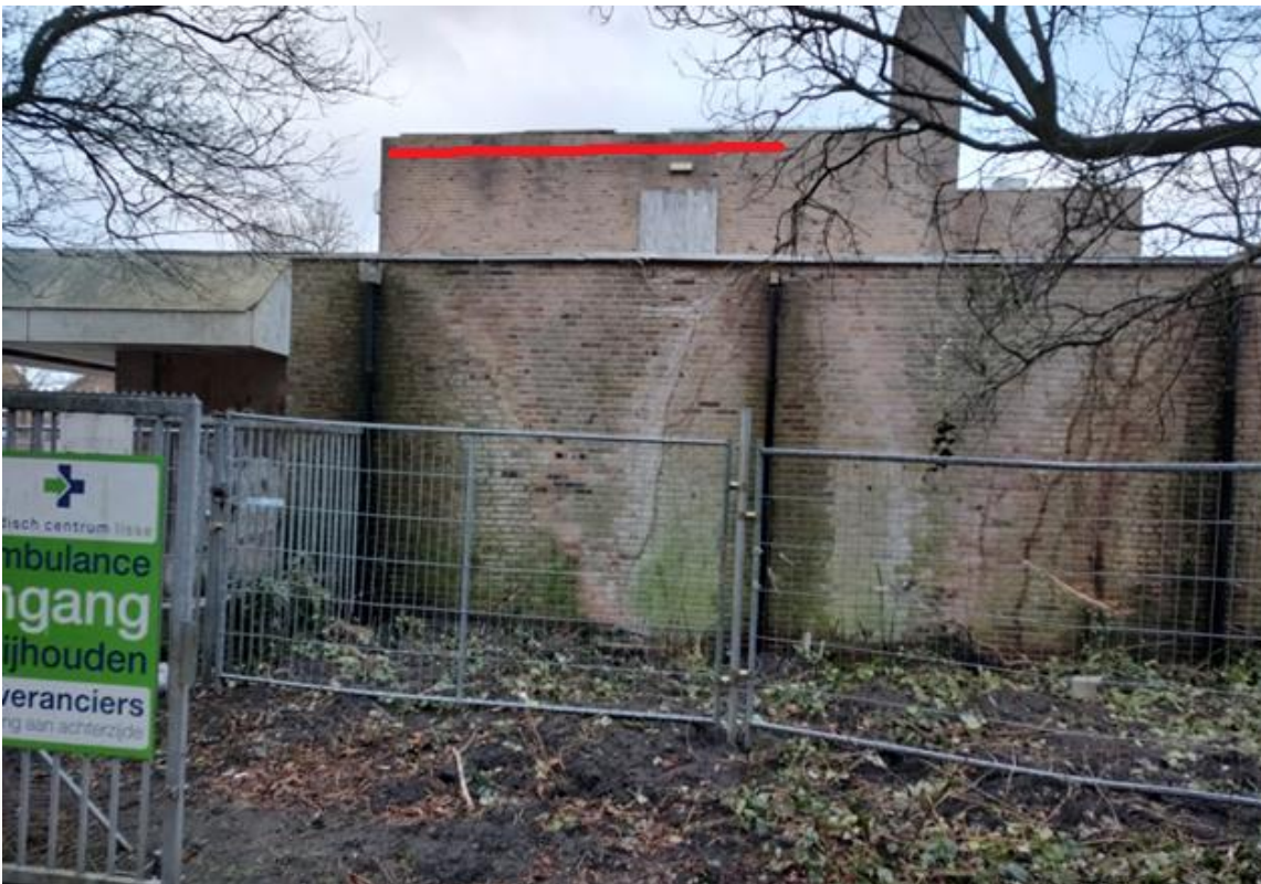
Foto van de oostkant van het gebouw, waar de dakbedekking eveneens los is.
