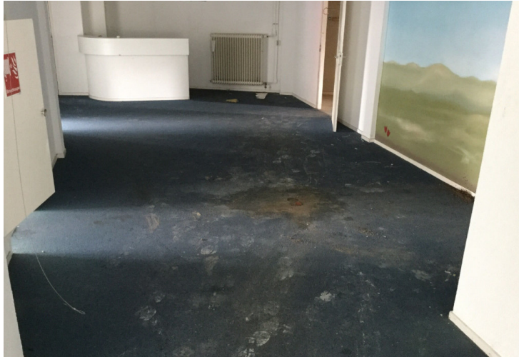
Foto 1 Overzicht van de onderzoekslocatie
