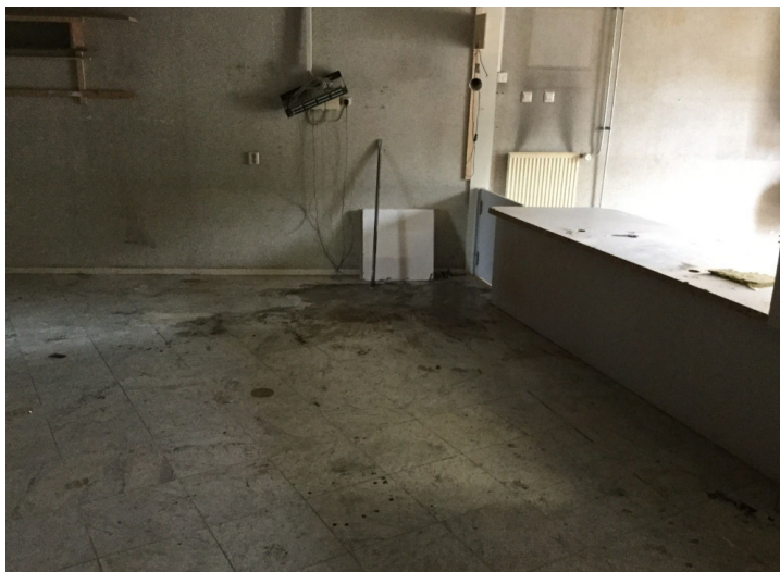
Foto 2 Overzicht van de onderzoekslocatie
