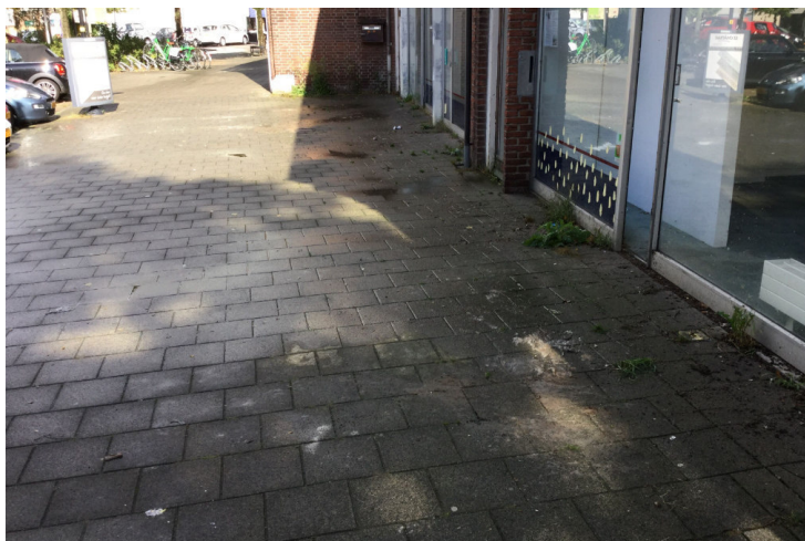
Foto 3 Overzicht van de onderzoekslocatie
